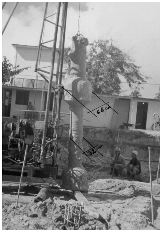
Figura 2 – Estaca extraída com dois bulbos.
