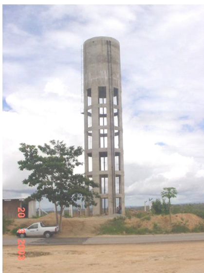
Figura 1. Reservatório em referência.
